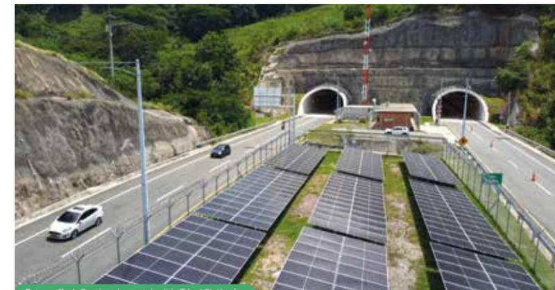
Fotografía 4. Granja solar portal salida Túnel Sinifaná.
