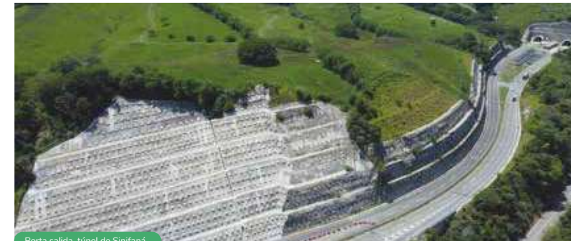
Porta salida, túnel de Sinifaná.
