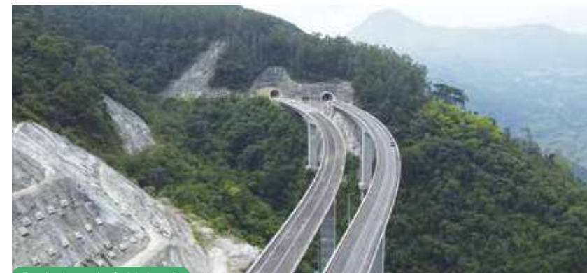
Portales de entrada, túnel de Amagá.
