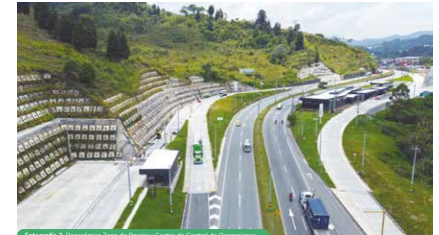
Fotografía 2. Panorámica Zona de Pesaje y Centro de Control de Operaciones.
