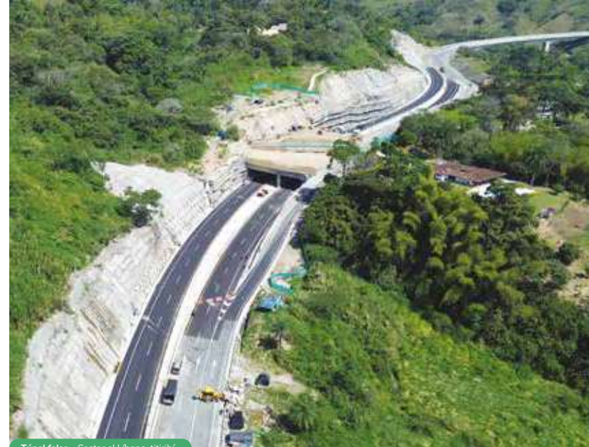
Túnel falso - Sector el Líbano, titiribí.
