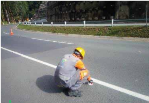
Instalación de tachas y bordillos no traspasables
