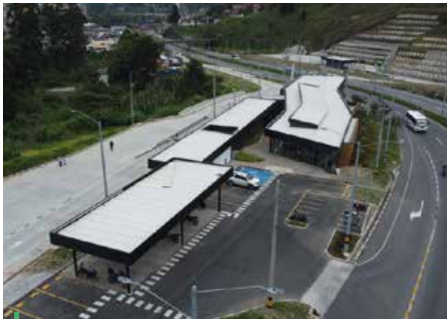
Fotografía 5. Centro de Control de Operaciones – CCO Caldas
