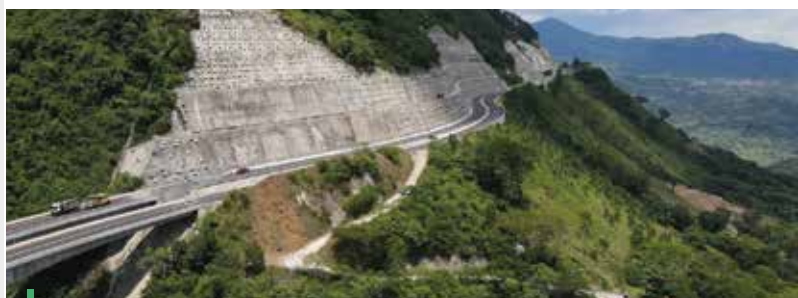
Fotografía 15. UF2, Titiribí, Vía a cielo abierto tramo 9
