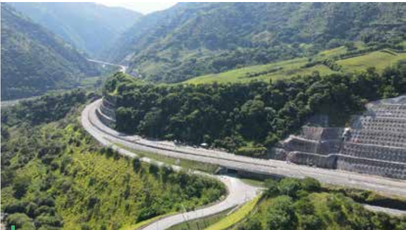
Fotografía 9. UF1, Venecia, Sector Sinifaná, Vía a cielo abierto tramo 3
