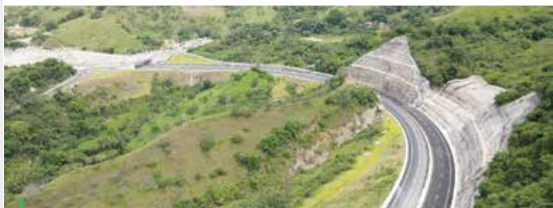
Fotografía 12. UF2, Titiribí, Sector Puerto Escondido, Vía a cielo abierto tramo 6
