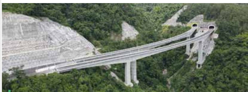
Fotografía 16. UF2, Titiribí, Puente 20/ Portal de entrada Túnel Amagá
