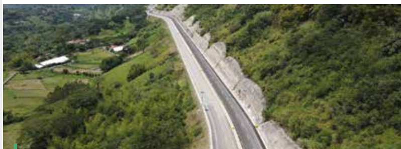
Fotografía 13. UF2, Titiribí, Vía a cielo abierto tramo 6
