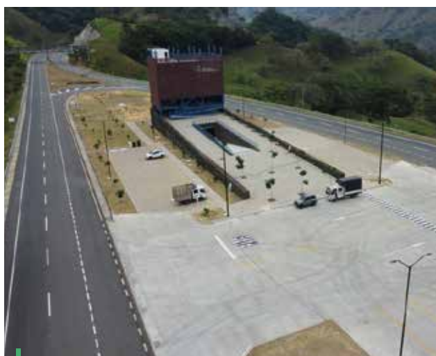
Fotografía 1. Área de Servicios – Bolombolo
