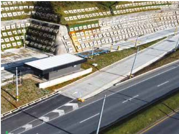
Fotografía 4. Área de Pesaje: Sentido Sur – Norte
