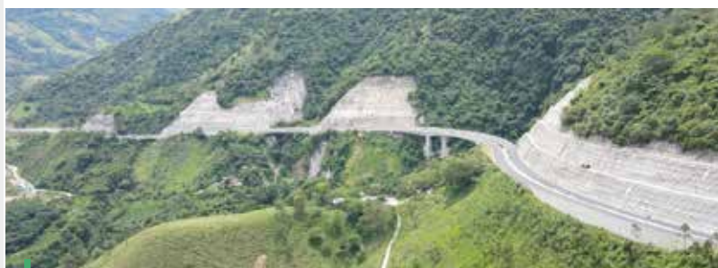
Fotografía 14. UF2, Titiribí, Vía a cielo abierto tramo 8
