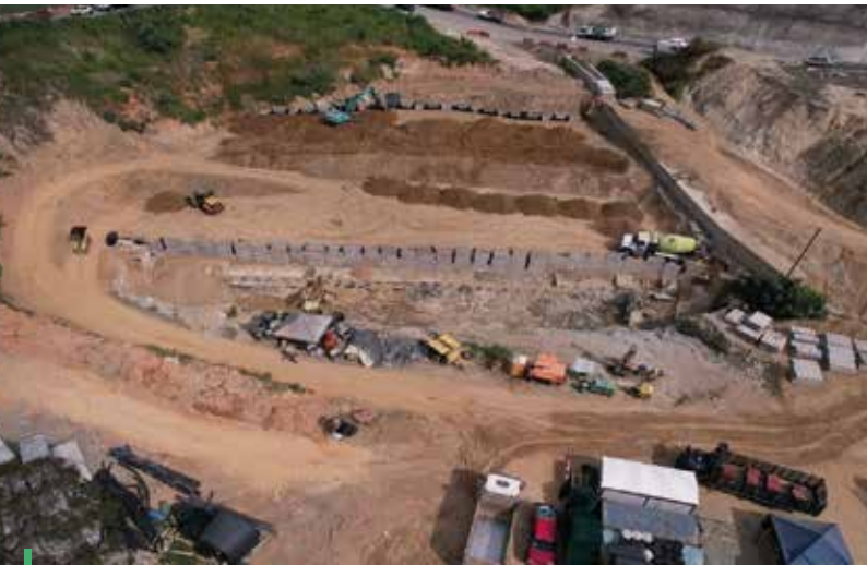
Fotografía 18. UF4, Amagá, Sector Paso Nivel, Obras Muro 15.
