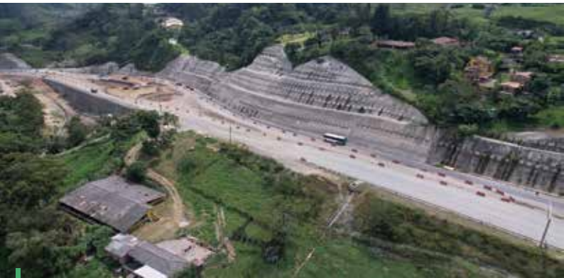
Fotografía 17. UF4, Amagá, Sector Carcafé, Obras Retorno 1
