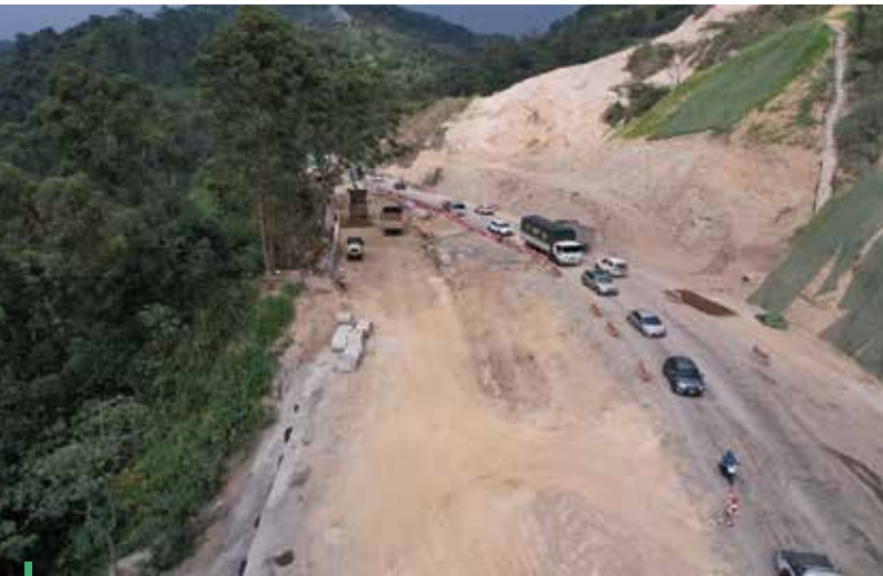
Fotografía 19. UF4, Amagá, Sector Paso Nivel, Obras Retorno 2.
