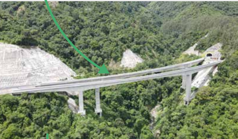
UF3- Calzada izquierda del túnel de Amagá.
