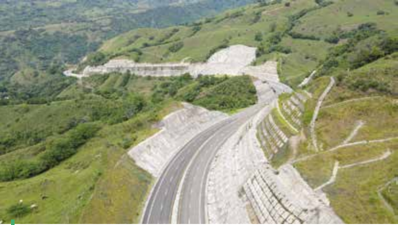
Fotografía 11. UF1, Titiribí, Sector Puerto Escondido, Vía a cielo abierto tramo 5.1
