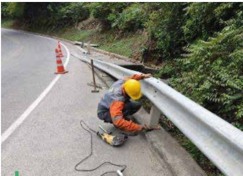
Instalación de Defensas metálicas
