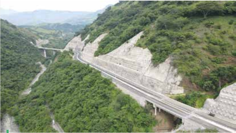
Fotografía 10. UF1, Titiribí, Sector Sinifaná, Vía a cielo abierto tramo 4
