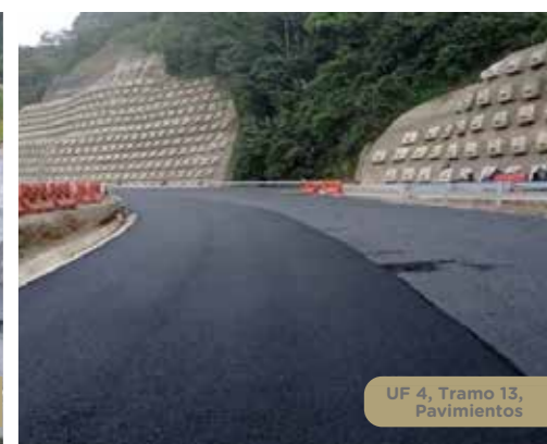
UF 4, Tramo 13 Avance pavimentos
