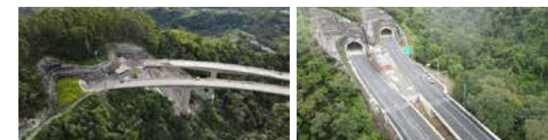
Túnel de Amagá: Longitud aprox. 3.6 km.
