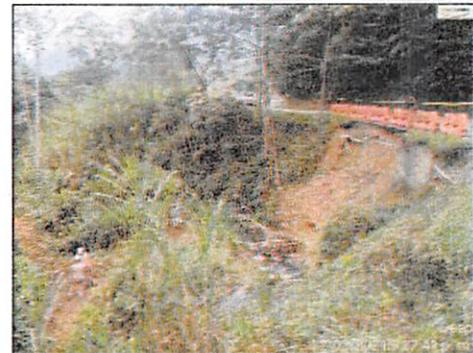
Socavación del talud inferior. PR 94+000 R.N.6003.
