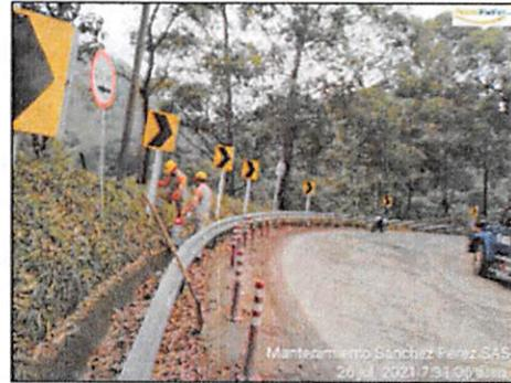
Cambio de señales verticales por medición de retroreflectividad PR 85+350 R.N.6003.
