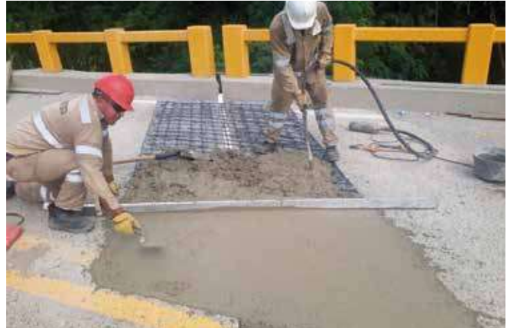
Vaciado y vibrado de concreto modificado puente Sinifaná. PR 56+450 RN 6003.
