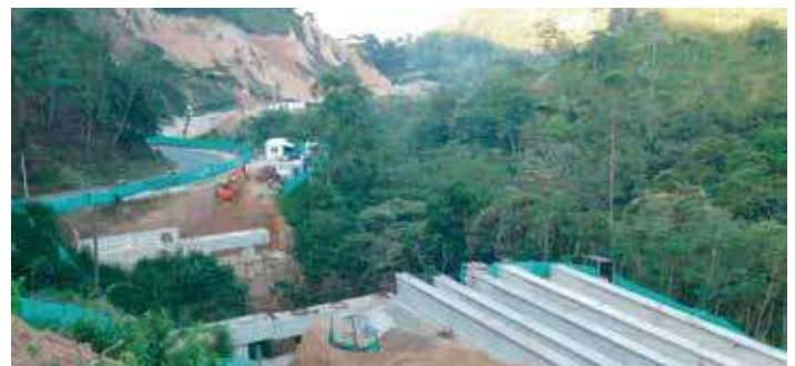
UF4, Construcción puentes 24 y 25.
