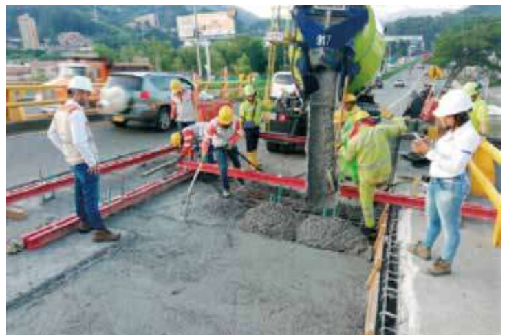
Vaciado y vibrado de concreto modificado (Puente la Tablaza) PR 60+450 RN 2509.
