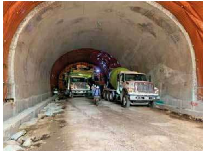
Vaciado de modulo de revestimiento del Túnel Sinifaná Izquierdo
