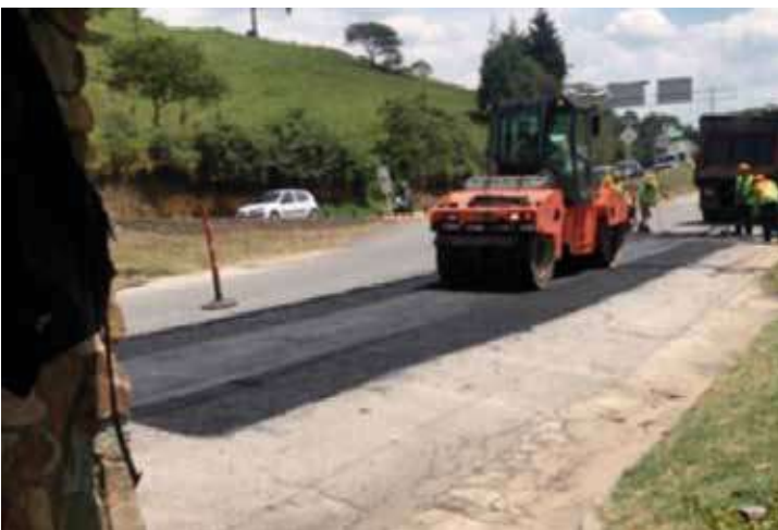
Extensión y compactación de mezcla asfáltica PR 54+000 R.N. 2509.
