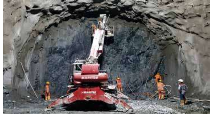
UF3, Túnel de Amagá Calzada Derecha, Frente Portal Salida.
