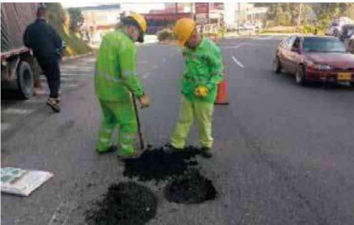
Reparación de baches con asfalto frio PR 60+030 R.N. 2509
