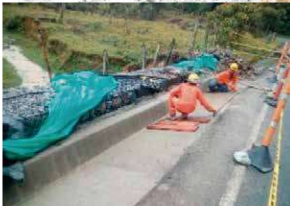
Muro en gaviones terminado y Preparación terreno y vaciado de cunetas.
