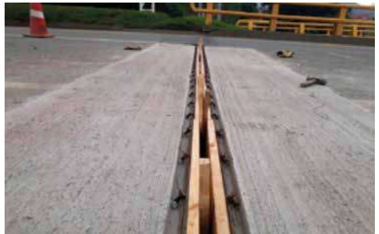
Instalación de anclaje y encofrado para guardacantón PR 54+810 R.N. 2509. (Puente Rio Medellín)
