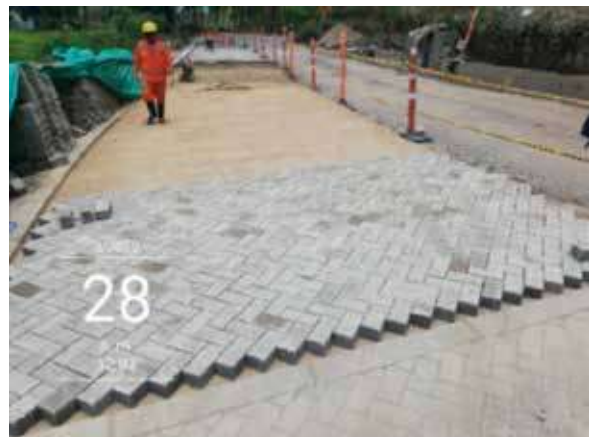
Instalación de pavimento articulado PR 84+050 RN 6003.
