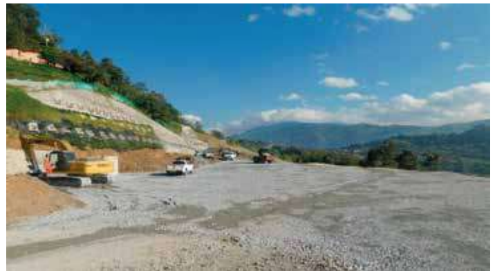
UF2, Tramo 12.2, Construcción vía a cielo abierto.
