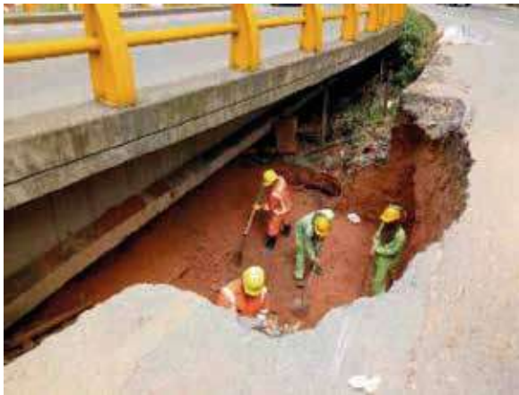
Pérdida de carpeta por socavación en estructura PR 59+620 R.N. 2509. Recuperación de la banca.
