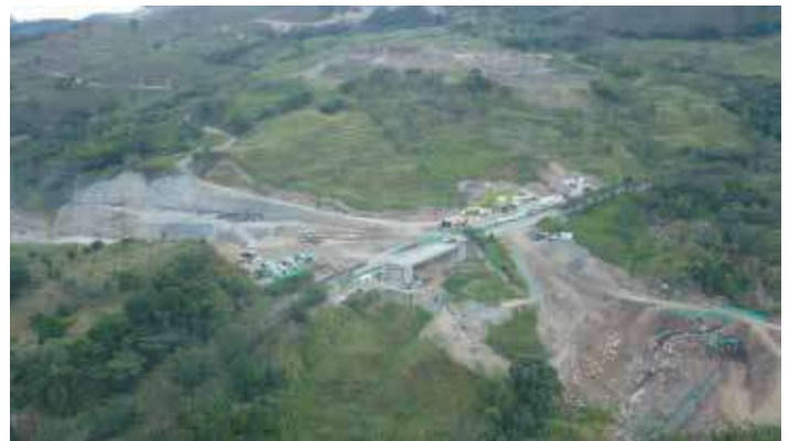
UF2, Tramo 5.2, Intercambiador Titiribí, puente 14.
