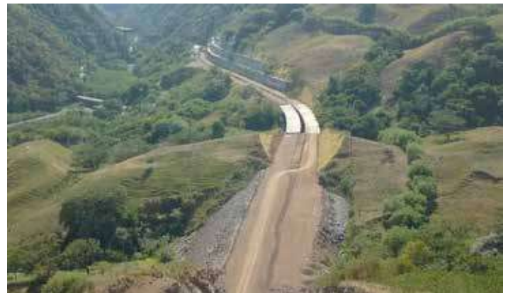
UF1, Tramo 3, Puente 6 terminado.
