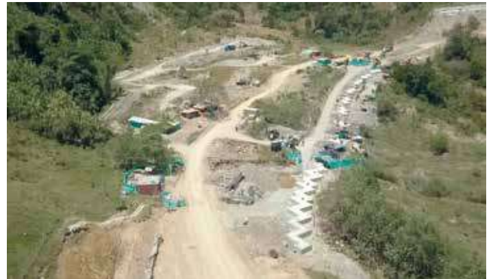
UF1, Estabilización Sector Crítico El Guamo.
