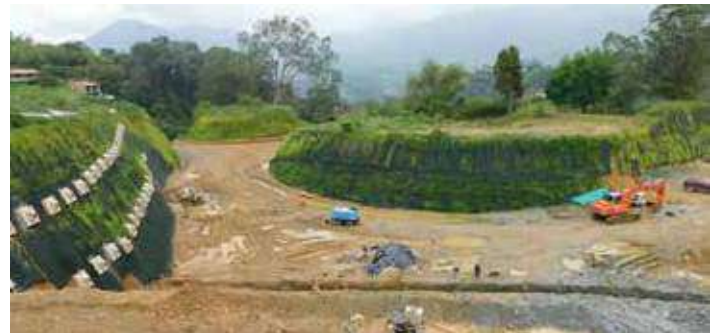
UF4, Vía de acceso al Portal de Entrada del Túnel de Amagá.
