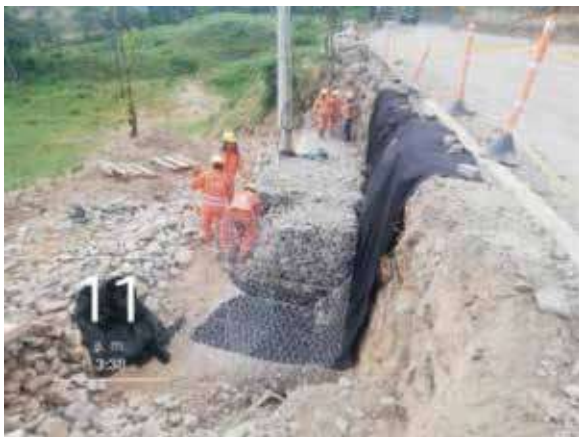
Instalación de Gaviones PR 84+000 RN 6003
