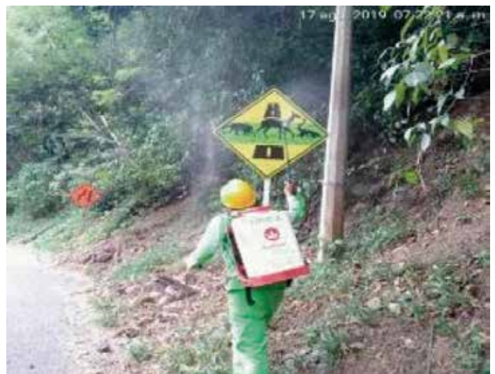
Lavado de señales verticales K01+200 El cinco-Venecia.
