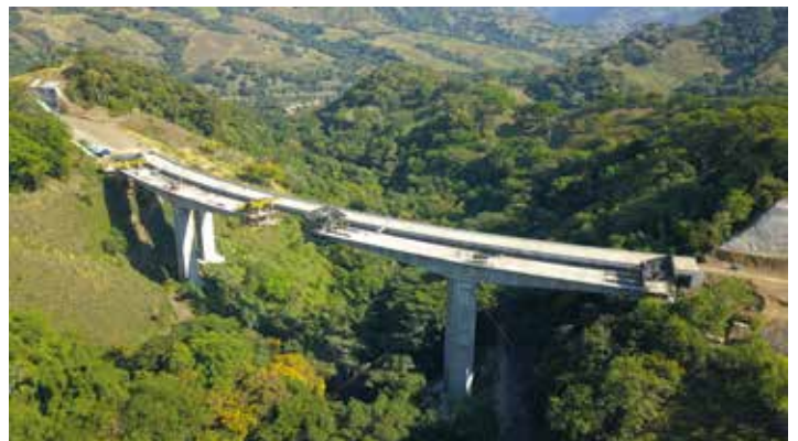
UF1, Tramo 1, construcción Puente 3 Calzada Derecha
