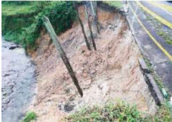
Socavación del talud inferior. PR89+000
