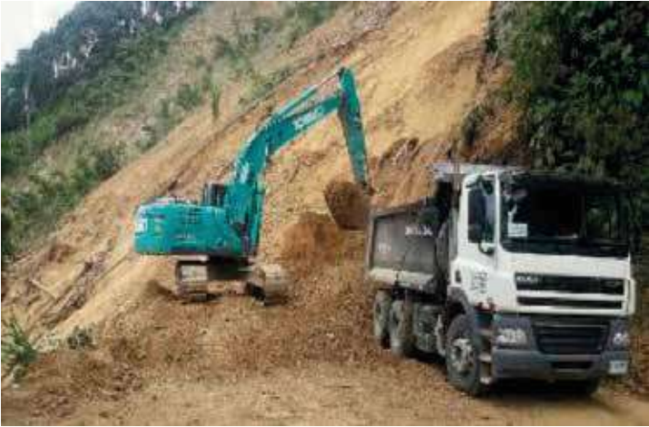
Remoción deslizamiento PR 78+600, R.N 6003
