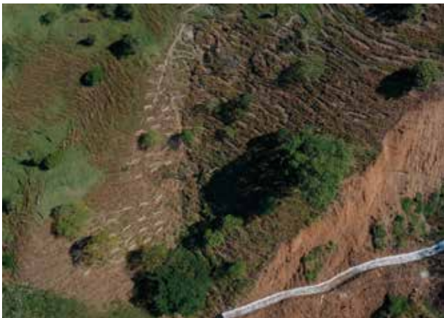
Trinchos lado Bolombolo Deslizamiento – Canal de Drenaje Bajo No. 3.
