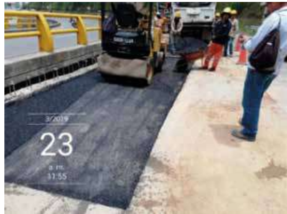
Extensión y compactación de carpeta asfáltica PR 59+620 R.N. 2509.
