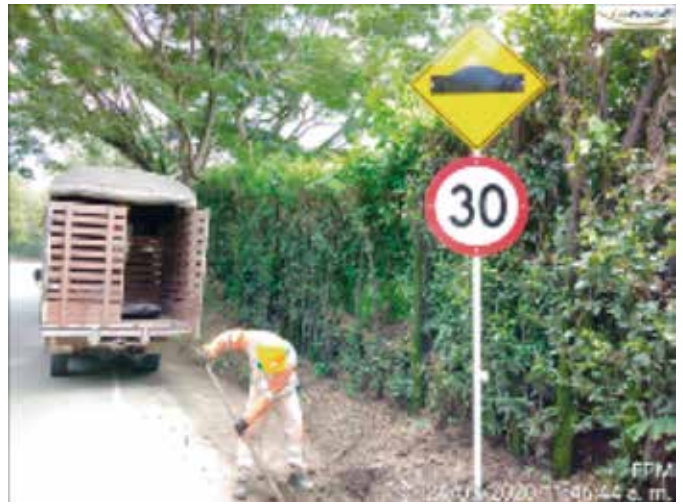
Instalación de señal vertical. PR 64+215 R.N.6003.
