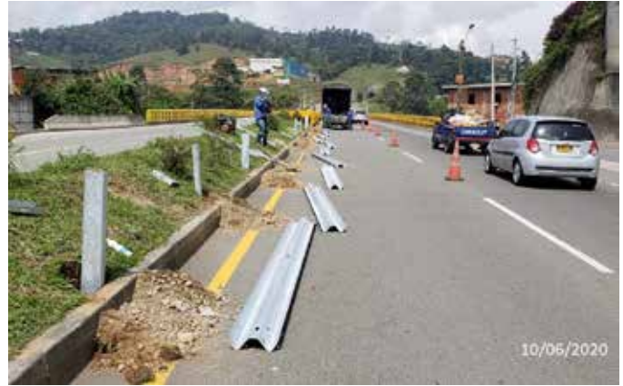
Instalación de defensas metálicas. PR 93+400 R.N.6003.
