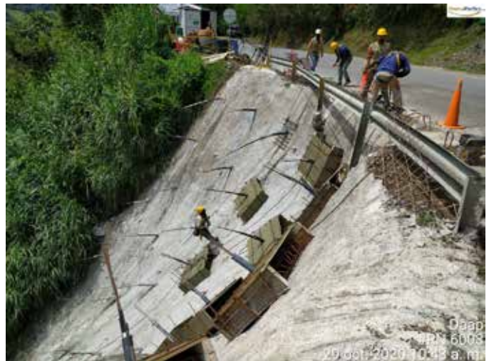
Estabilización de talud por deslizamiento en PR 63+950 R.N. 6003.
