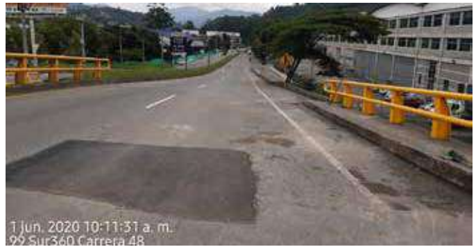
Reparación carpeta asfáltica puente Tablaza. PR 60+450 R.N.2509.
