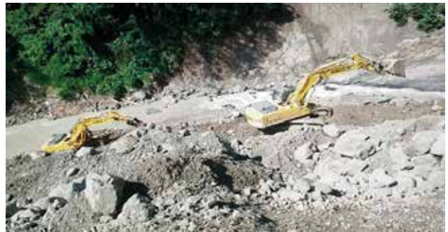
UF1, Tramo 4 Desembalse Quebrada Sinifaná
