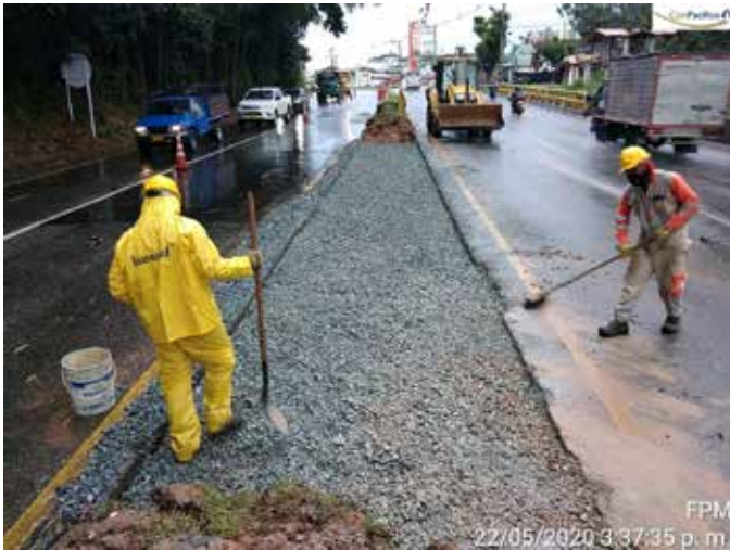
Construcción de Bypass. PR 63+900 R.N.2509.
