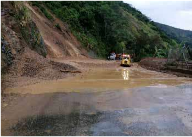
Remoción deslizamiento PR 78+600, R.N 6003
