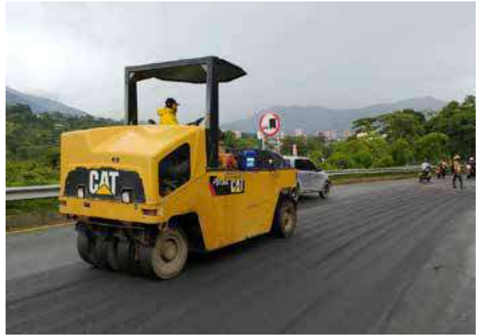
Extensión y compactación de mezcla asfáltica PR 62+480 R.N. 2509.
