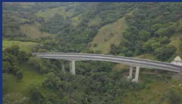
UF1, Tramo 1, construcción Puente 3.
