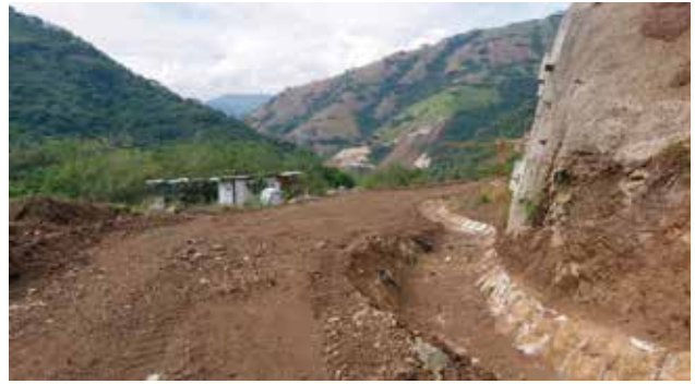
UF1, Tramo 4 Limpieza y mantenimiento de canales sector Sinifaná
