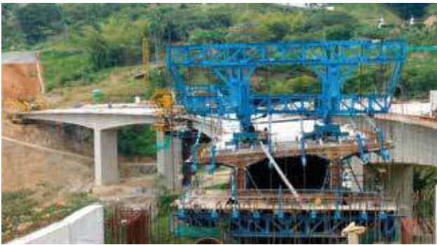
UF2, Tramo 7, Avance Puentes 15
