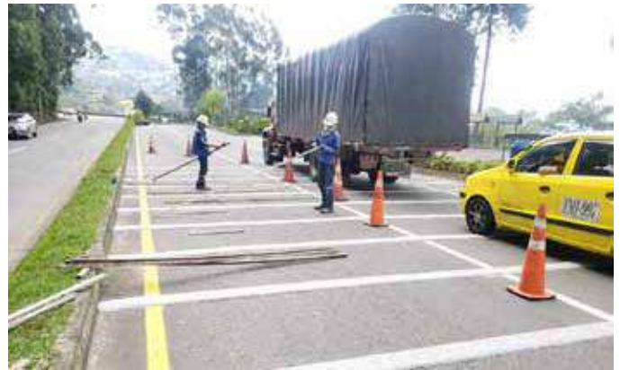
Instalación de bandas alertadoras. PR 59+550 R.N.2509.
