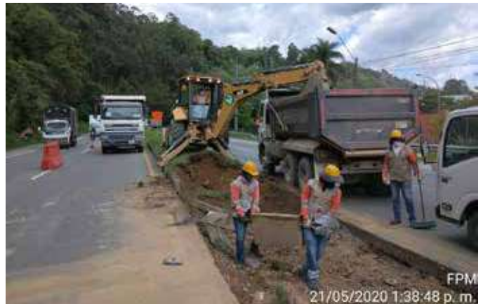
Construcción de Bypass. PR 63+900 R.N.2509.
