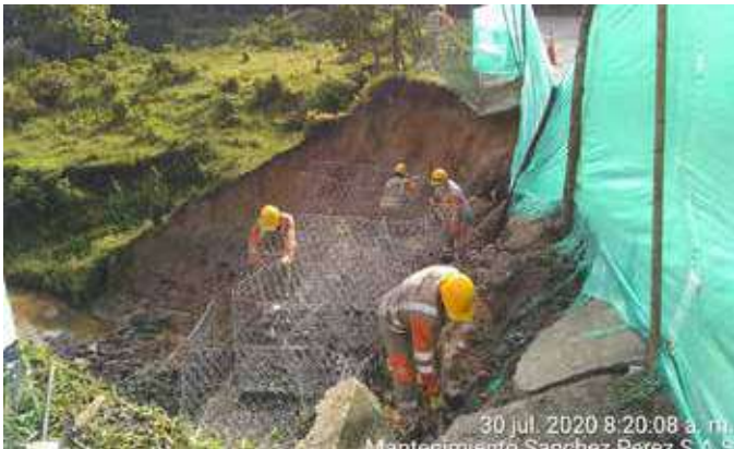
Socavación del talud inferior. PR 89+000 R.N.6003.
