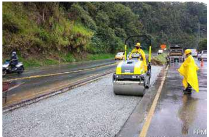
Construcción de Bypass. PR 63+900 R.N.2509.
