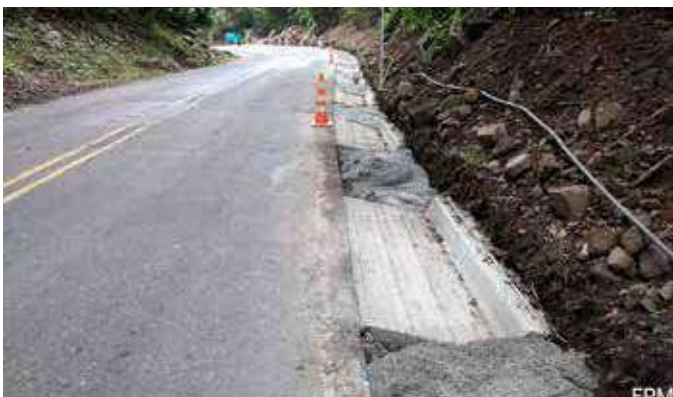
Reconstrucción de cunetas PR 51+240 R.N.6003.
