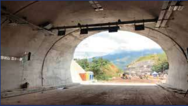
Finalización de revestimiento del Túnel Sinifaná Izquierdo.
