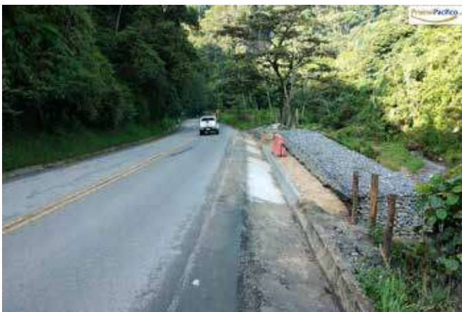
Muro en gaviones terminado.
