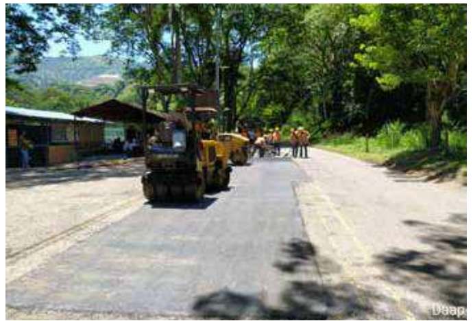
Extensión y compactación de carpeta asfáltica PR 50+680 R.N. 6003.
