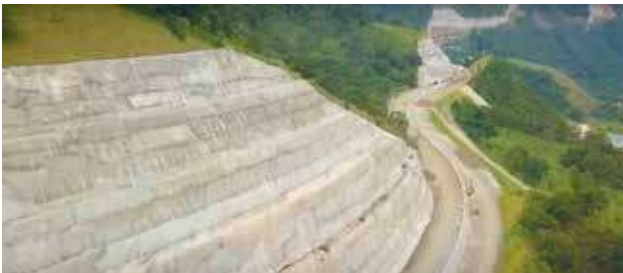
UF2, Tramo 7, Avance Puentes 15
