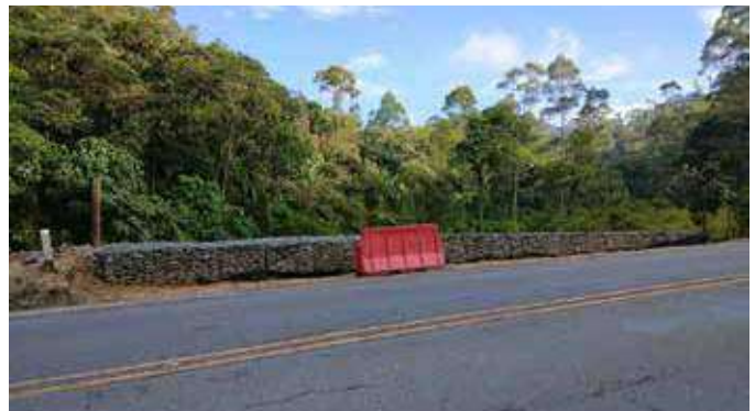
Instalación de Gaviones PR 89+000 RN 6003.
