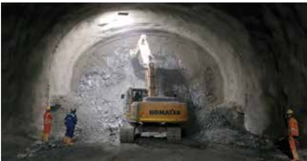
UF3, Túnel de Amagá Calzada Derecha, Frente Portal Salida.
