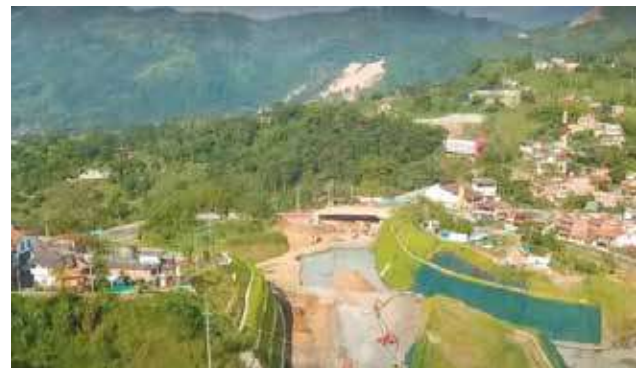
UF4, Tramo 12.4 Construcción Intercambiador Camilo Cé
