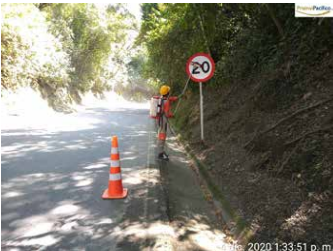
Lavado de señales verticales PR 62+400 R.N.6003
