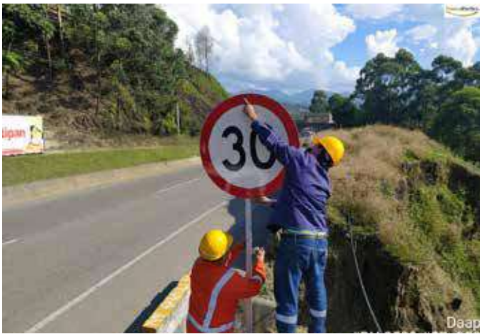
Cambio de señales verticales por medición de retroreflectividad PR 57+600 R.N.2509.
