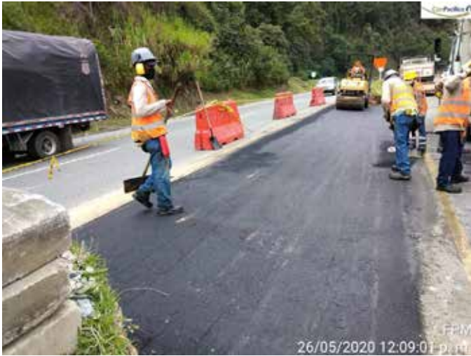
Construcción de Bypass. PR 63+900 R.N.2509.
