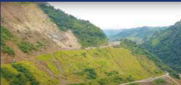
UF1, Tramo 4 Trabajos de mitigación Sector Sinifaná
