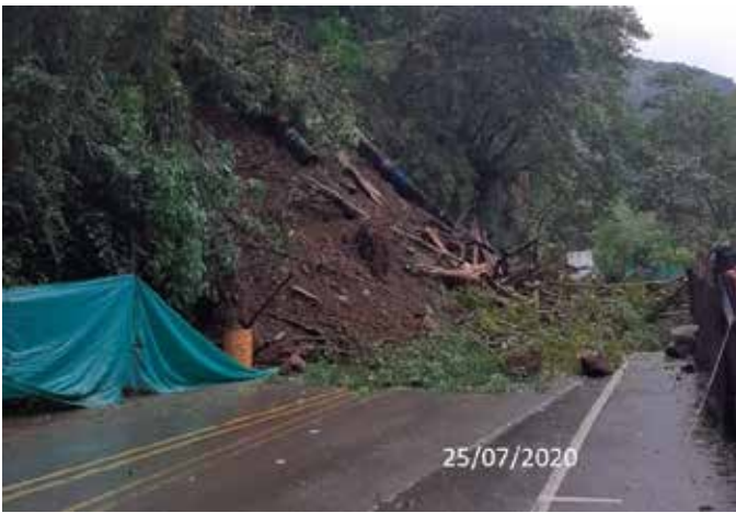
Remoción deslizamiento PR 57+030, R.N 6003
