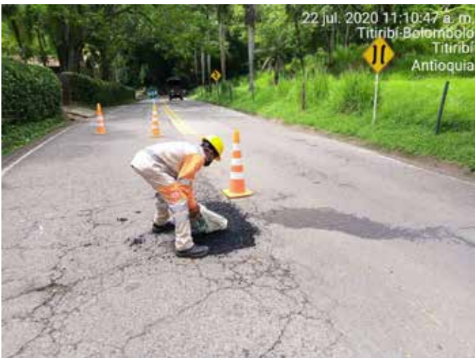
Reparación de baches con asfalto frío PR 51+150 R.N. 6003
