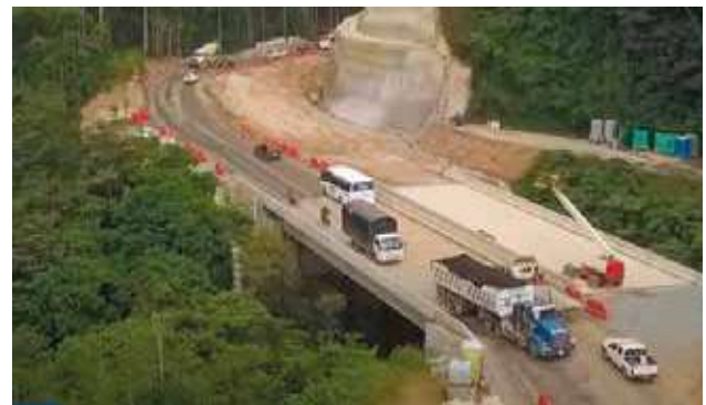
UF4, Construcción puentes 24 y 25.
