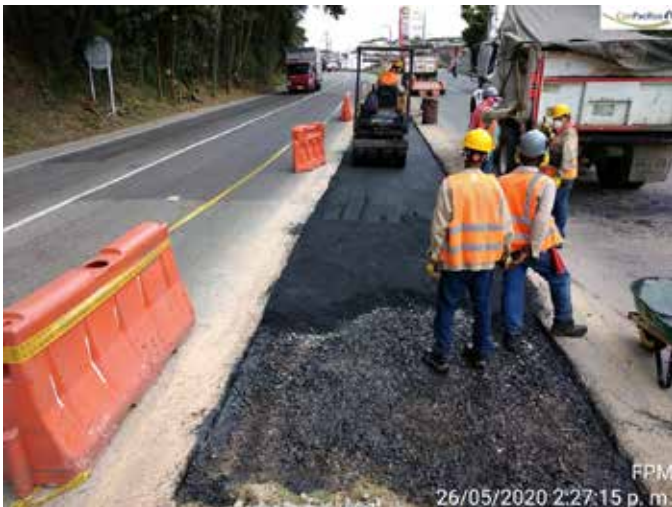
Construcción de Bypass. PR 63+900 R.N.2509.
