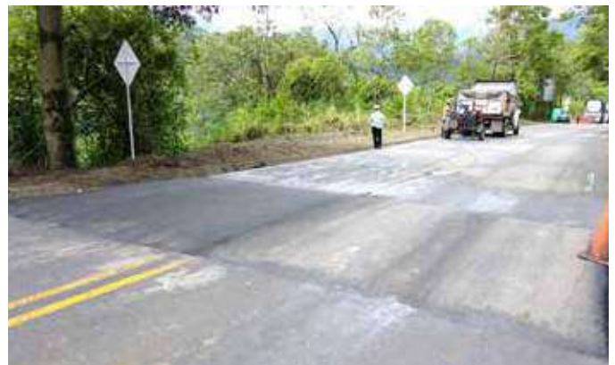
Instalación de bandas alertadoras. PR 64+215 R.N.6003.
