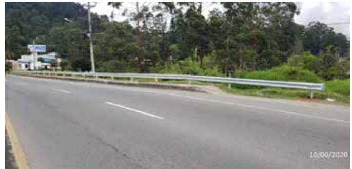
Instalación de defensas metálicas. PR 59+980 R.N.2509.
