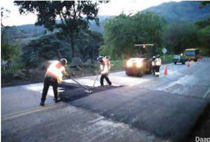
Instalación de tachas. PR 67+185 R.N.6003.
