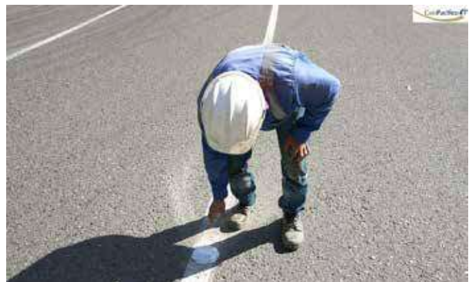
Instalación de tachas. PR 57+950 R.N.2509.
