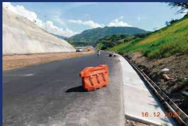
UF1, Avance en obras de superficie.
