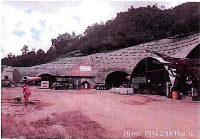
Fotografía 5 –Túnel de Amagá Calzada Derecha y Calzada Izquierda
