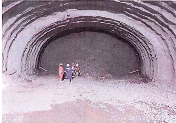
Fotografía 8 –Túnel de Amagá Calzada Derecha
