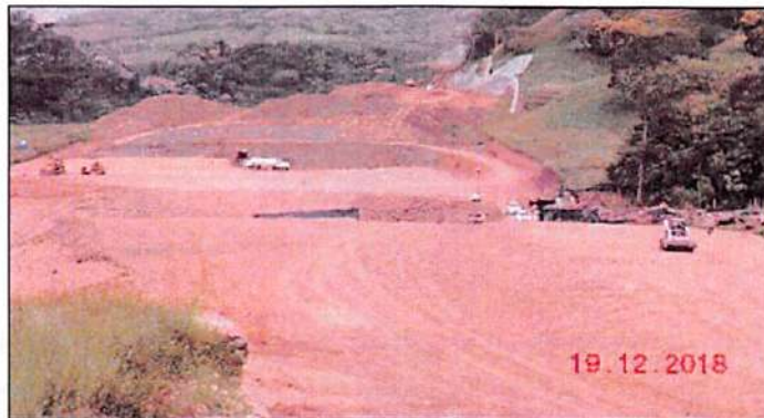
Fotografía 1 – Área de servicio intervención en taludes y terraplenes
