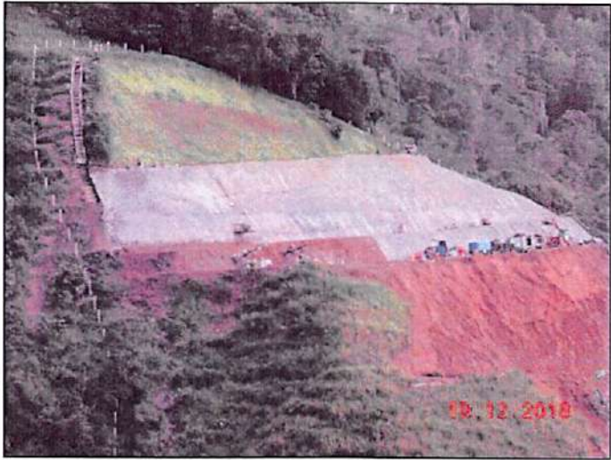
Fotografía 6 –Sostenimiento de taludes Tramo 8 K18+110 – K18+180
