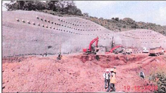
Fotografía 3 – Portal de Entrada Túnel de Sinifaná
